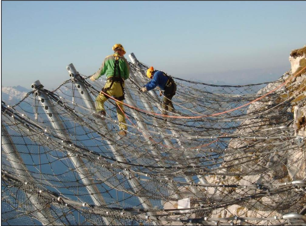
**Abb. 6:** Endmontage von GEOBRUGG Netzen
