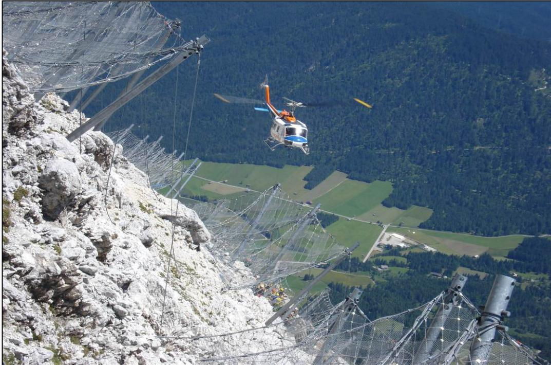
**Abb. 10:** Transport der Netze mittels Hubschrauber
