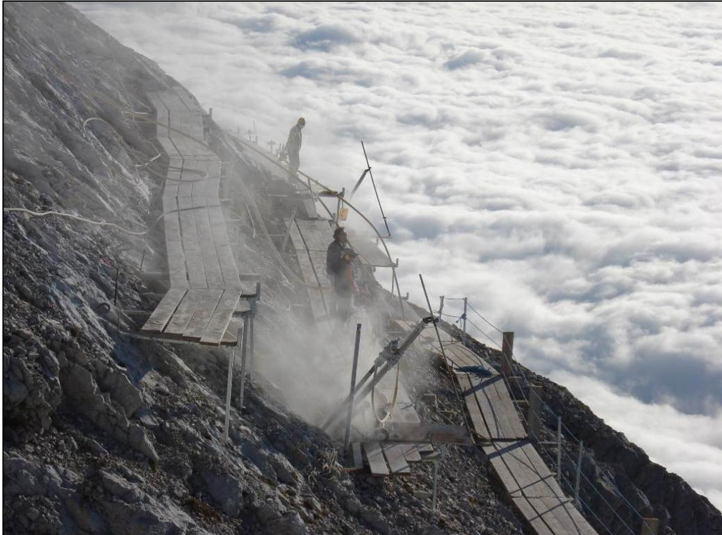
**Abb. 8:** Drei Bohrebenen erfordern die Errichtung von drei Manipulationsbrücken in unterschiedlichen Ebenen.
