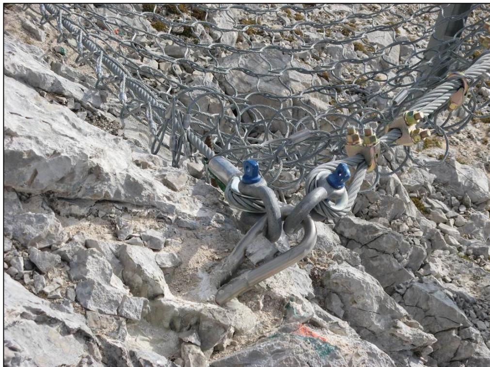
**Abb. 11:** Seilankerkopf im Detail.
